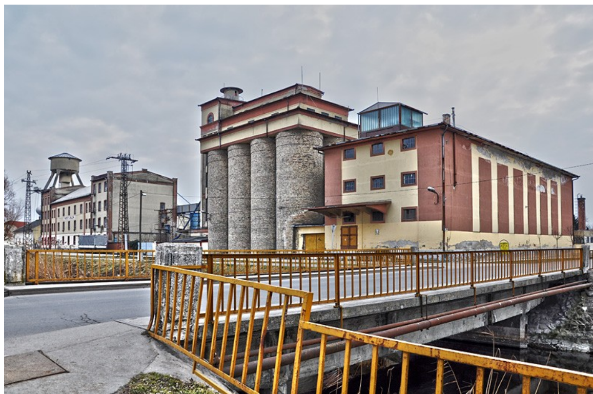
2. ábra: Margit Malom épülete
